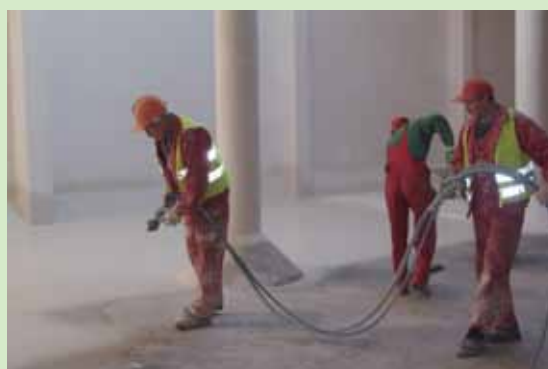
Spremnik pitke vode, Tarnów, Poljska
