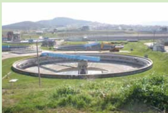
Pročistač otpadnih voda, Istanbul, Turska
