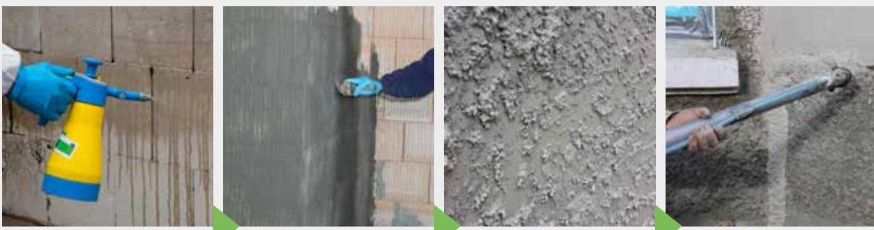
Uklonite staru žbuku. Ispunite pukotine i rupe s KÖSTER Reparturnim Mortom. Nanelite KÖSTER Polysil TG 500 na površinu kako biste blokirali soli i ojačali podlogu.
