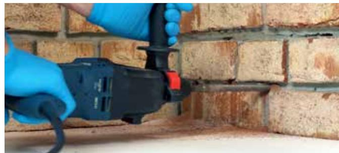
2 U unutarnjem zidu buše se rupe s razmakom od 10 cm jedna od druge i dubine 40 cm (Debljina zida: 45 cm i 30 cm iznad nivoa).
