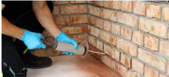
3 Bušotine se čiste od prašine ispuhivanjem prašine bušotine zrakom pod pritiskom.
