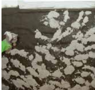
Nanošenje Sanacijskog šprica KÖSTER Sanacijskom žbukom
