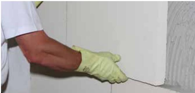
**4** Zatim se KÖSTER Hidrosilikatne Ploče utiskuju na zid i izravnavaju. Daske i sučeljeni spojevi moraju biti potpuno zalijepljeni.
