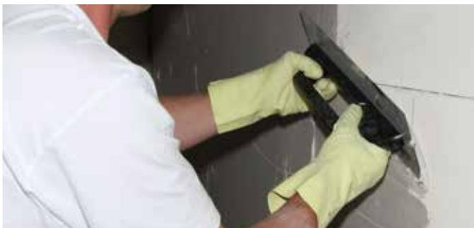
**5** Nakon toga se cijela površina nanosi slojem KÖSTER Hidrosilikatnog Ljepila SK u maksimalnoj debljini od 2 mm.
