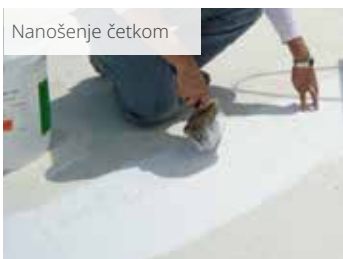
4 KÖSTER Superflis se nanosi na prvi svježi sloj
