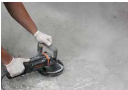
1 Priprema podloge
