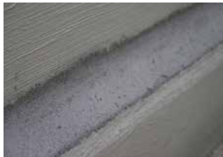
2 Ugradnja holkera sa KÖSTER Reparturnim mortom
