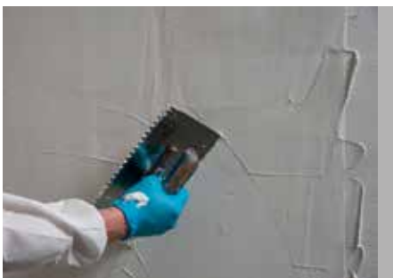
4 KÖSTER Superflis se nanosi na prvi svježi sloj
