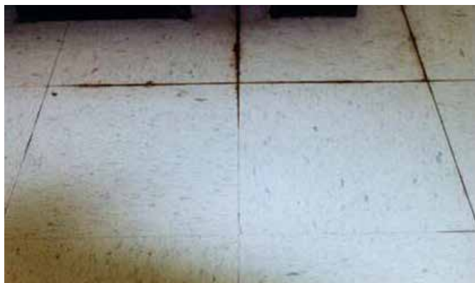
Vlaga i visoke pH vrijednosti otapaju ljepila...
