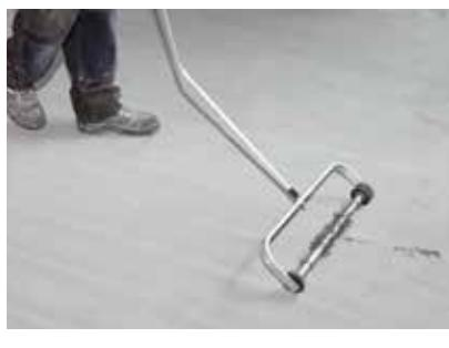
4. Kada se pjeskarenje izvodi čeličnom sačmom, površina se čisti magnetskom metlom. Prikupljena sačma može se ponovno koristiti.
