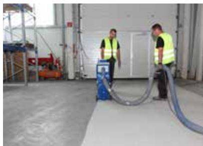
1. Podloga se priprema pjeskarenjem. Ovim postupkom uklanjuju se stari premazi, kao i onečišćene i nestabilne betonske površine do sloja koji se može premazati.
