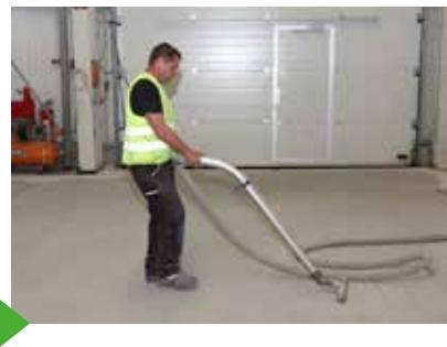
9. Nakon stvrdnjavanja, višak materijala se uklanja vakuumskim čišćenjem.
