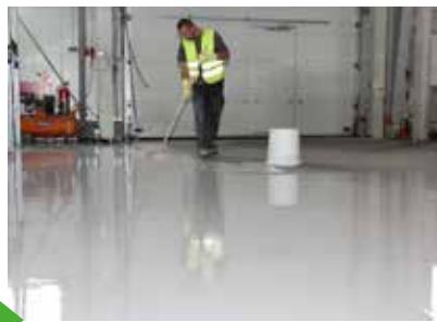
13. Nakon što je materijal postavljen na pripremljenu podlogu, KÖSTER LF-VL se može ravnomjerno rasporediti pomoću odgovarajućeg alata za glaćanje. Materijal je samorazlivajući.
