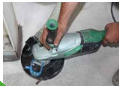
3. Detalji kao što su kutovi i rubovi moraju biti pripremljeni mehaničkim brušenjem.
