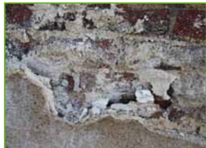
Typischer Schaden durch Salzausblühungen
