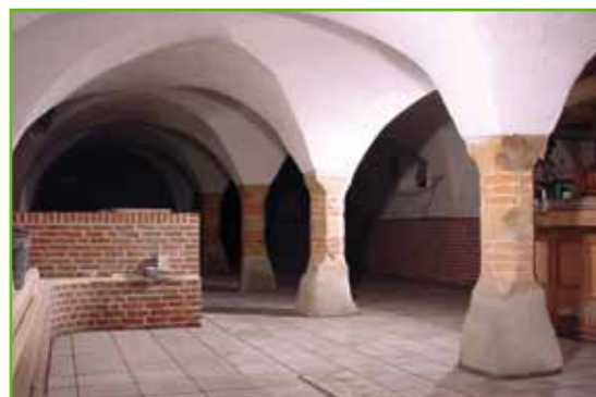
Das Mauerwerk dieser Gebäude wurde mit KÖSTER Sanierputz 2 weiß instand gesetzt.
