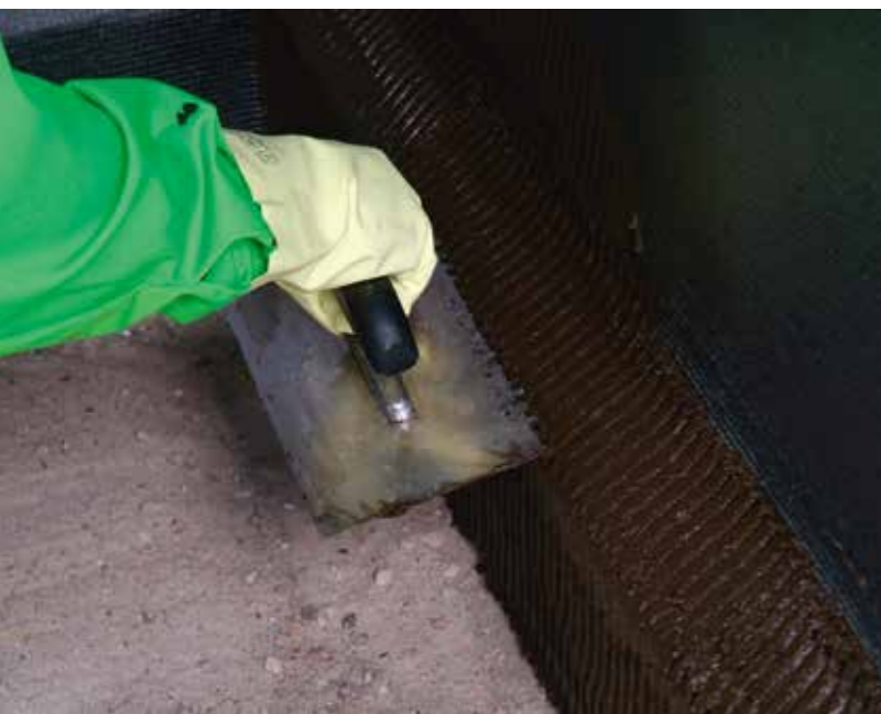
Ugradnja hidroizolacijskog premaza preko prethodno izvedenog holkera na spoju pod-zid
