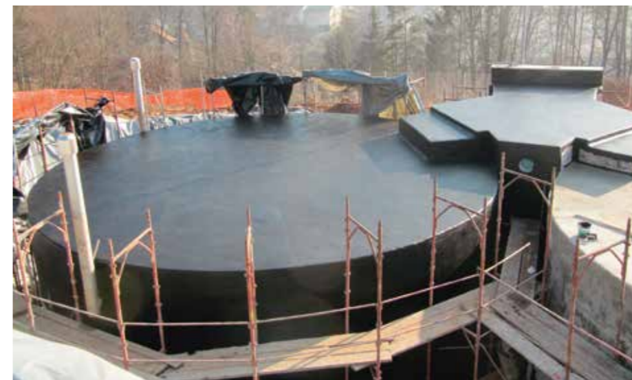
Hidroizolacija vodospreme
