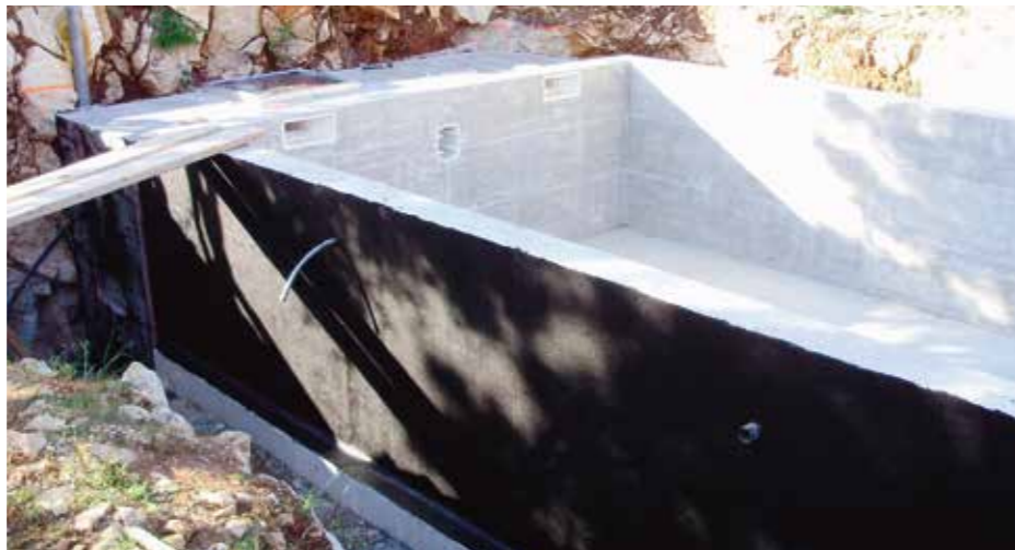
Hidroizolacija školjke bazena sa vanjske strane
