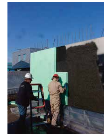
Uranjanje toplinske XPS izolacije u svježi sloj KÖSTER-a Deuxan 2K
