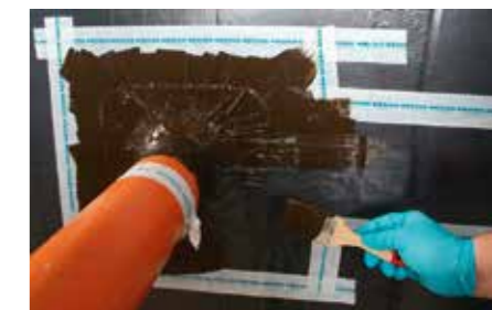
Varenje ljepenke uz plastične prodore je vrlo riskantno i sporo – 1K premaz KÖSTER KBE Tekuća Folija omogućava daleko jednostavniju i bržu ugradnju
