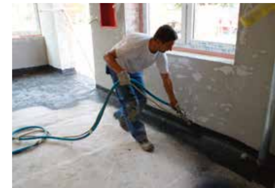
Dvostruko brža ugradnja može se postići strojnim špricanjem (KÖSTER Deuxan Professional)
