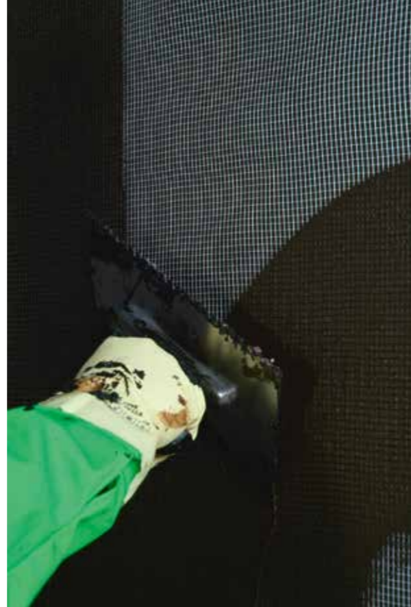
KÖSTER Armaturna Mrežica - uranjanje staklene, alkalno-otporne mrežice u prvi, još svježi sloj premaza
