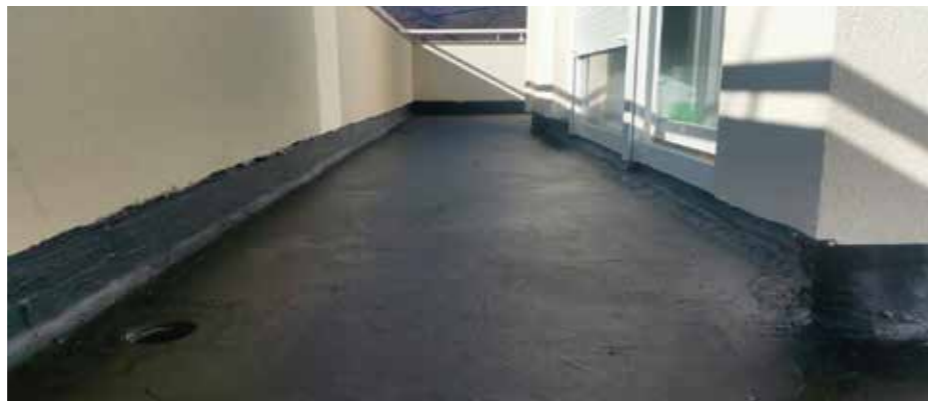
Hidroizolacija terase iznad negrijanog prostora
